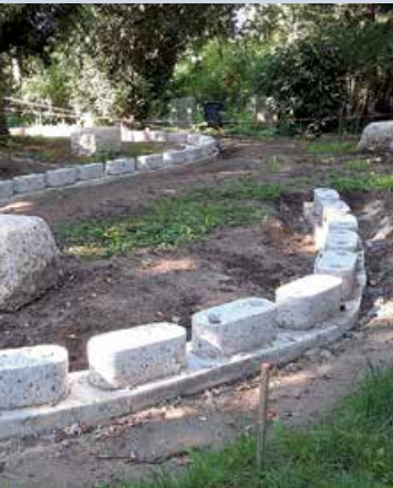
Fundament des Grabmals
